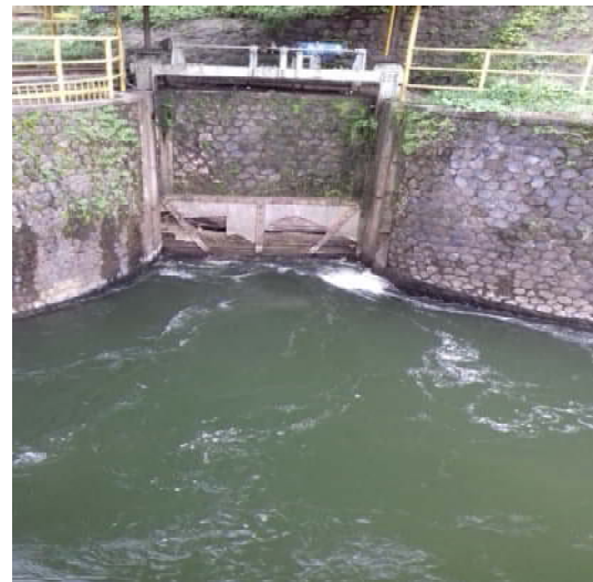
Gambar 3 Melakukan pengecekan di bagian pintu pengambilan air
