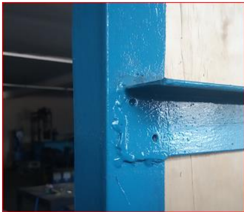
Gambar 5 Rangka yang sudah di las
